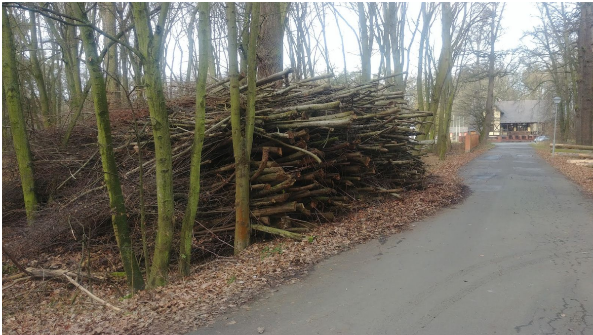
Větve z prořezu zasahující do vozovky, ul. Obora, stav k 4. lednu 2020.
